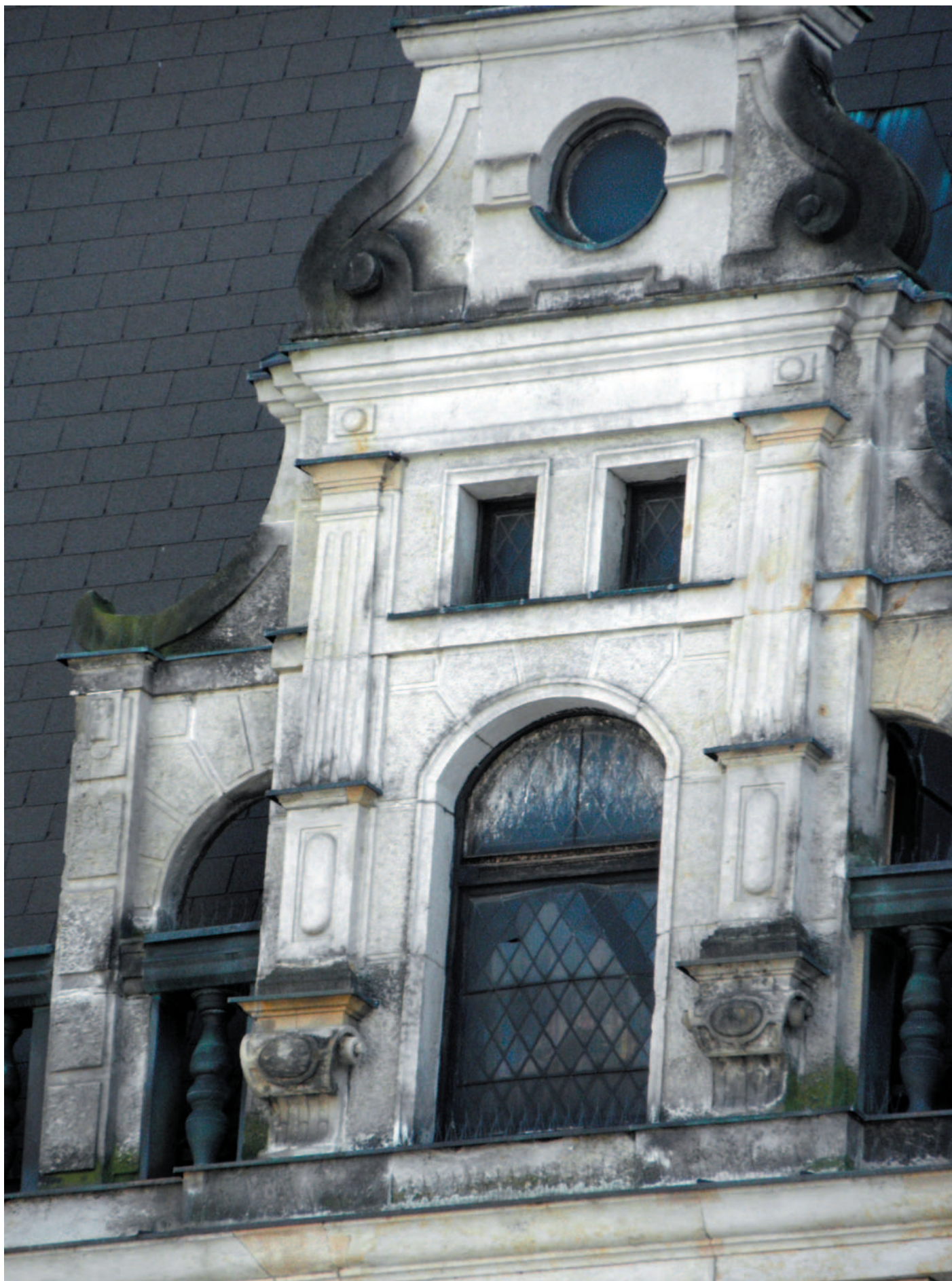
Čtvrtý portál sníženého půdního prostoru. Na celkové fotografii střechy směrem k divadlu je vpravo. Výplně všech čtyř oken jsou v ploše zachovalé. Jejich plochy jsou hodně deformované a jejich skla jsou nánosem nečistot slepá. V dolní výplni spodního okna je rozbitý kosočtverec. Vitraje jsou dožilé. Přístup do sníženého prostoru půdy je z rohové vyvýšené místnosti ve třetím patře.
