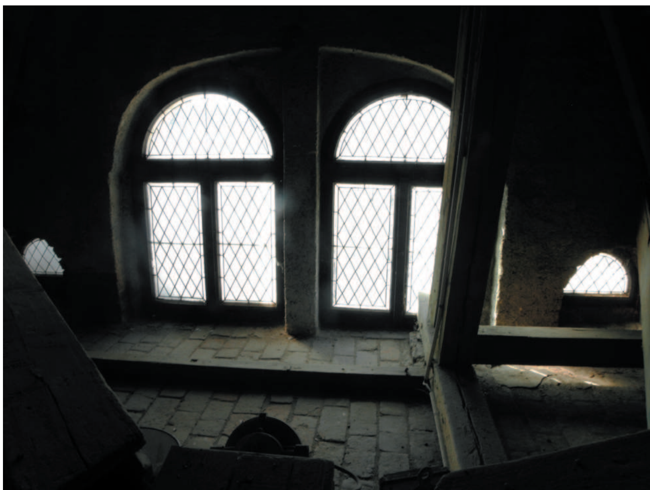
Pohled na okna s vitrajemi velkého štítu přední strany radnice. Vitraje jsou v ploše kompletní ale olověná vazba je dožilá a výplně jsou uvolněné a ve spodní části prosedlé.
