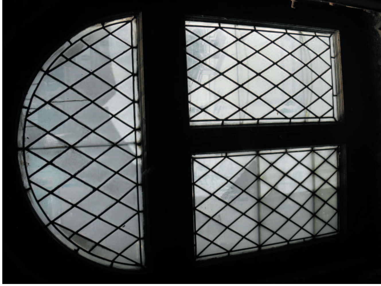
Vitraje oken věžních štítů přední a pravé strany věže. Na jedné výplni již scházejí zpevňovací kovové výztuhy.
