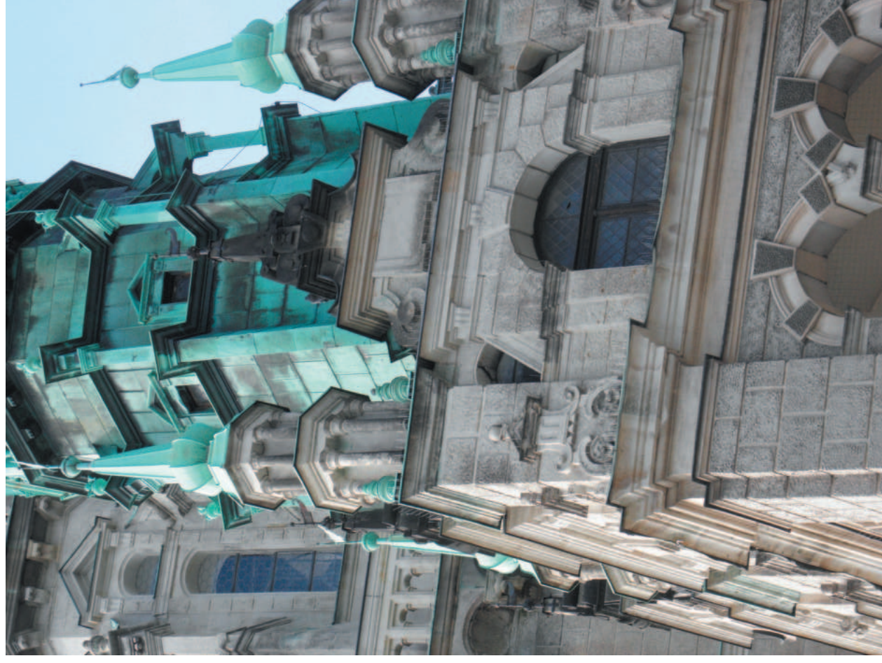
Pohled na pravou věž přední strany radnice z přední a pravé strany s okny osazenými vitrajemi. Ve střední části věže je opět osm menších okének osazených vitrajemi. Po stranách věžních štítů jsou opět zaslepené trojúhelníkové otvory. Na výplních dolních oken je vidět zvlnění ploch výplní. Jsou zde vidět i uvolněné kovové výztuhy které již neplní svou zpevňovací funkci.
