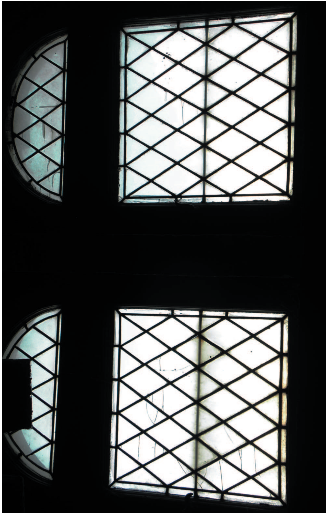
Vitraje horních dvou oken jsou na mnoha místech popraskané.
