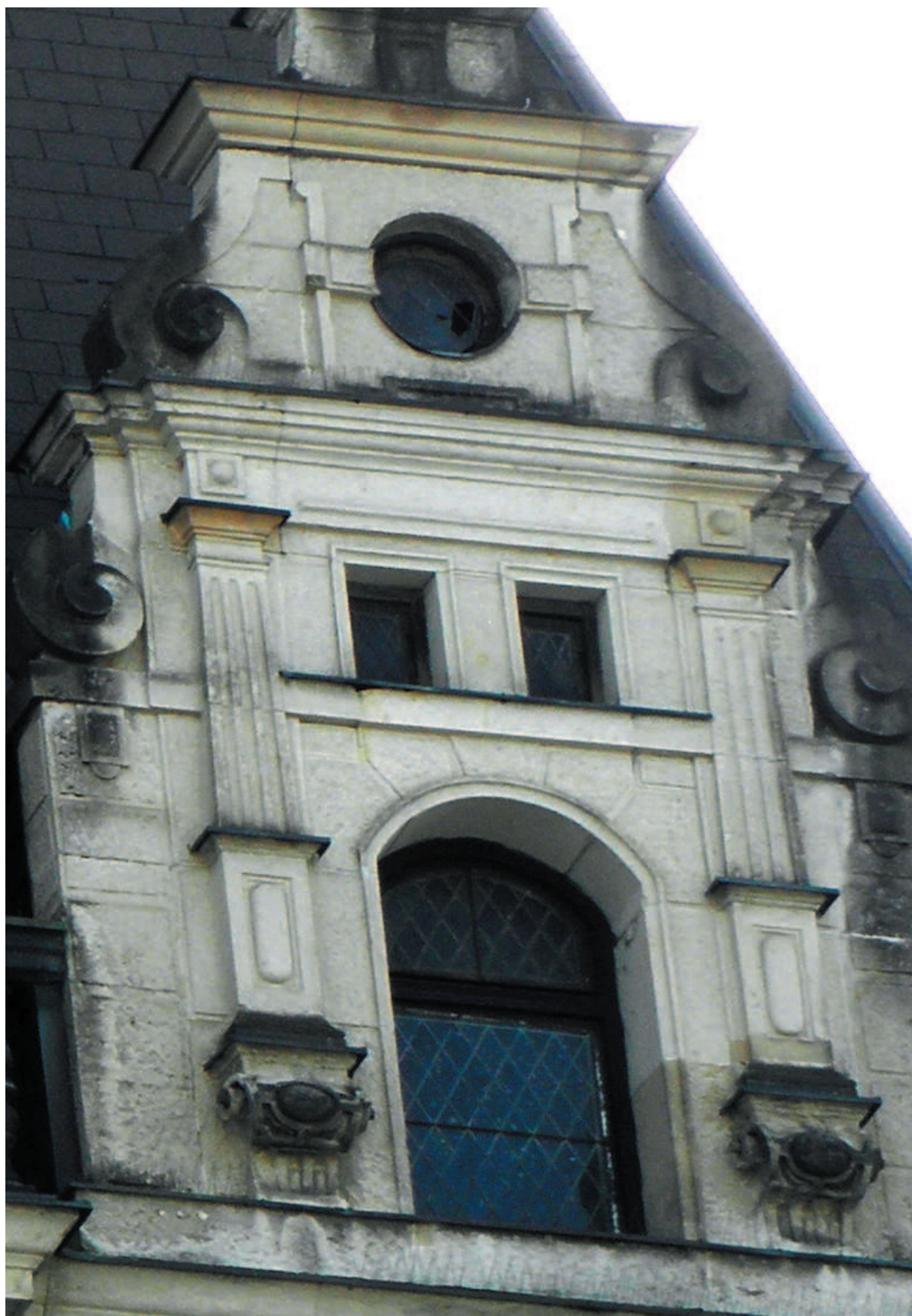
Třetí portál půdy. Výplně všech čtyř oken jsou v ploše zachovalé. Jejich plochy jsou deformované a jejich skla jsou nánosem nečistot slepá. Vitraje jsou dožilé. Přístup z vnitřní strany k oknům s vitrajemi je omezený.
