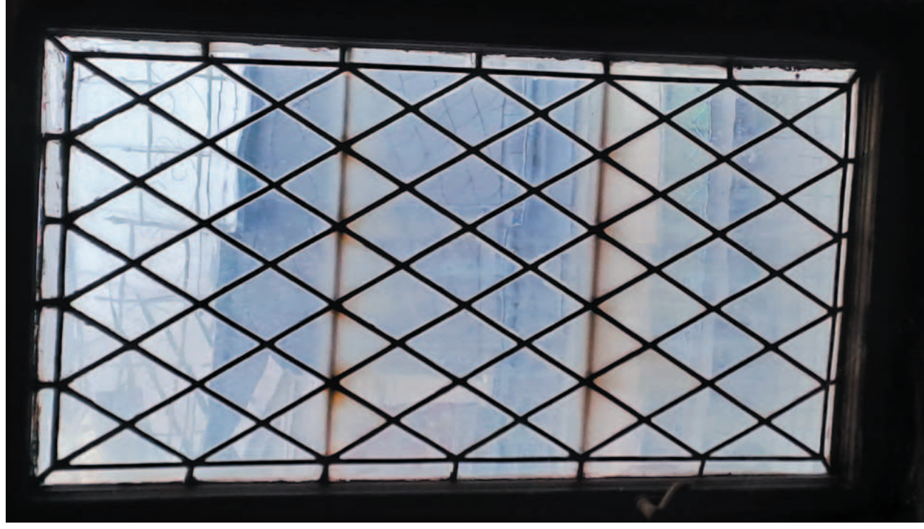
Vitrage horního a dolního okna velkého štítu umístěné v levé místnosti. U horního okna jsou ve spodní výplni poškozeny dva kosočtverce a u výplně dolního okna v horní části schází jeden díl bordury a výplň je uvolněná v horní části z rámu.
