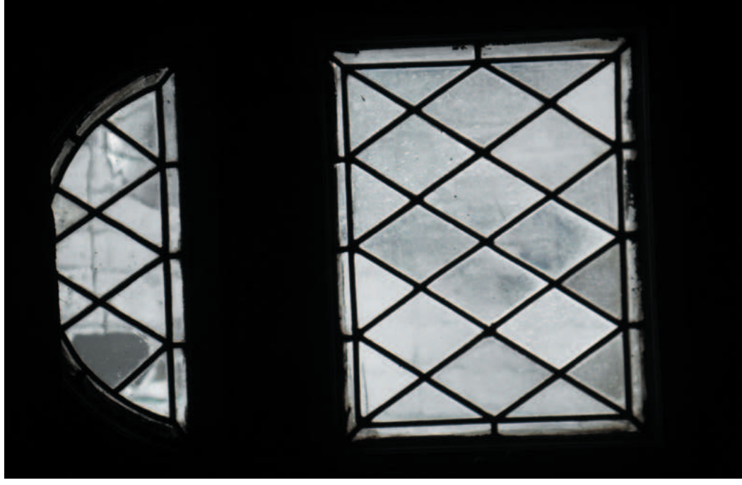
Vítraje okének levé strany směřující do atria radnice. Foceno bez blesku. Na prvním snímku je vidět poškození výplní. Na všech snímcích je vidět značné znečištění výplní. Výplně jsou dožilé.
