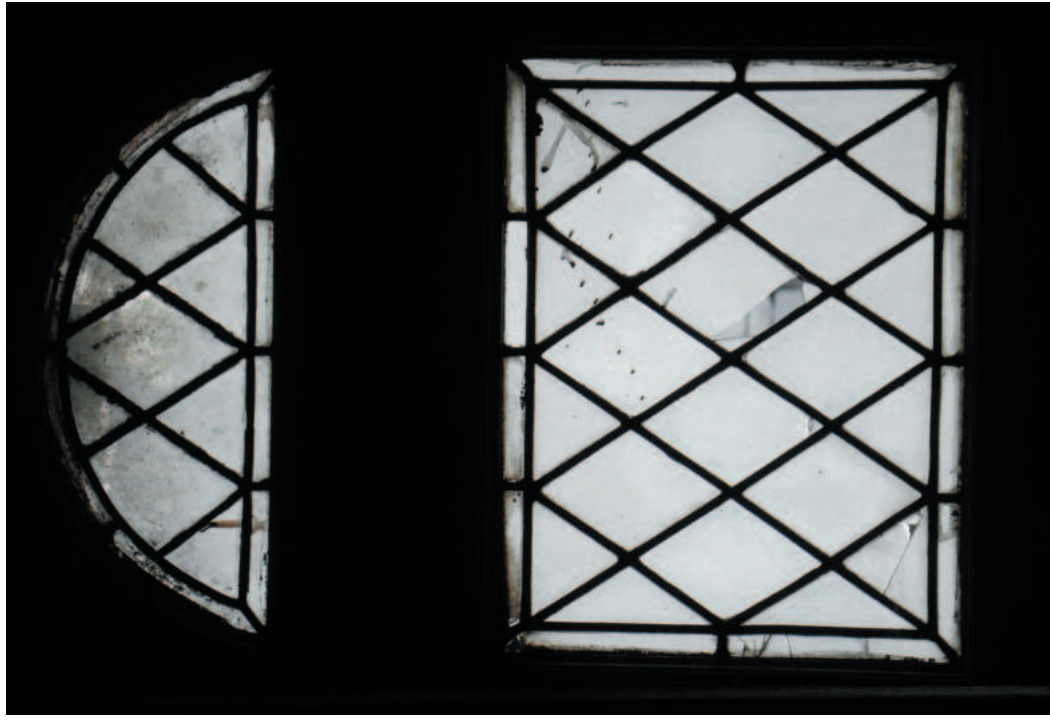
Vítraje okének levé strany směřující do atria radnice. Foceno bez blesku. Na prvním snímku je vidět poškození výplní. Na všech snímcích je vidět značné znečištění výplní. Výplně jsou dožilé.
