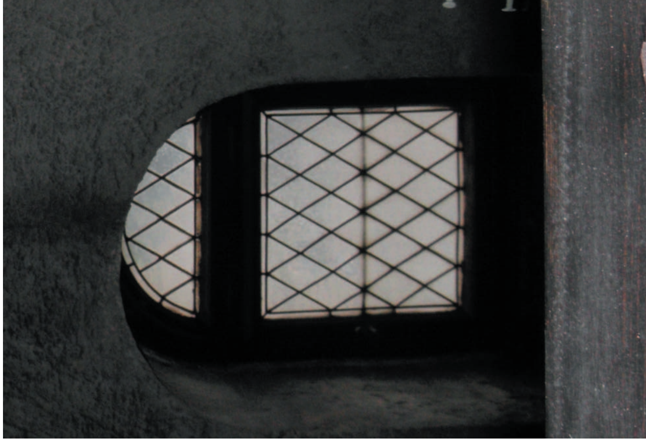
Bližší pohled na dvě výplně velkého portálu. Plochy výplní oken jsou zvlněné. U výplně obdélníkového rámu jsou odpadlé kovové výztuhy a na jejích místech je jen jejich špinavý otisk.
