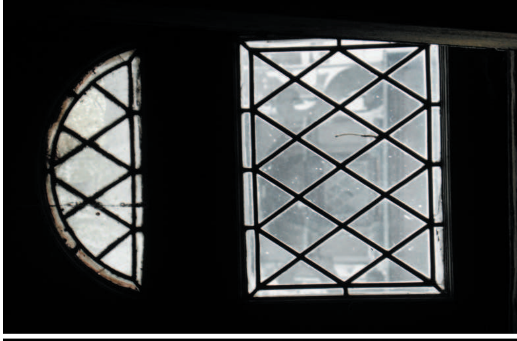
Vítraje okének levé strany směřující do atria radnice. Foceno bez blesku. Na prvním snímku je vidět poškození výplní. Na všech snímcích je vidět značné znečištění výplní. Výplně jsou dožilé.
