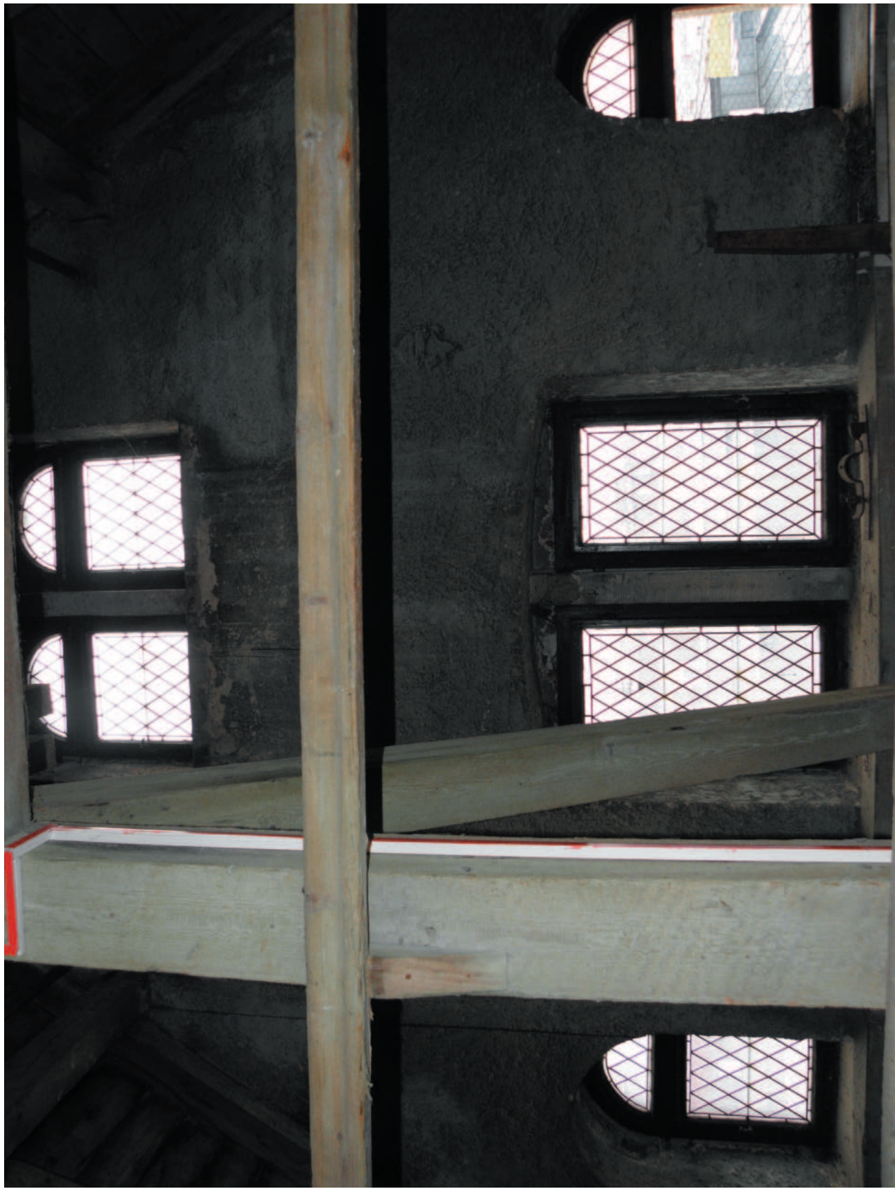
Okna třetího – velkého štítu. Spodní vitrajová výplň okna na pravé straně schází. Je tam jen rám osazený pleťvem. Vitraje jsou dožilé a značně znečištěné.
