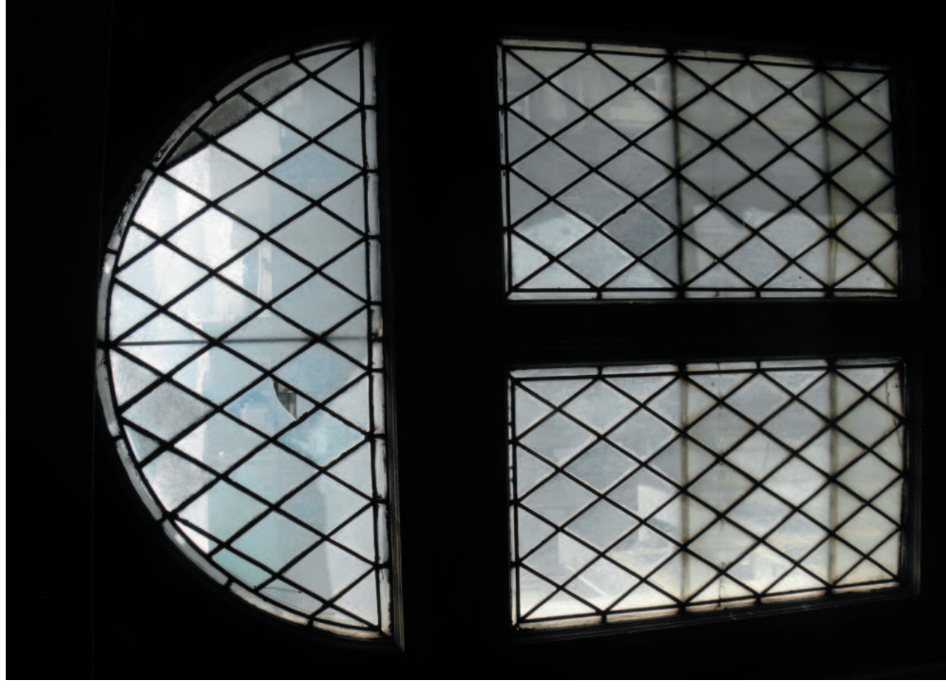
Vitraje oken věžních štítů přední a pravé strany věže. Na jedné výplni již scházejí zpevňovací kovové výztuhy.
