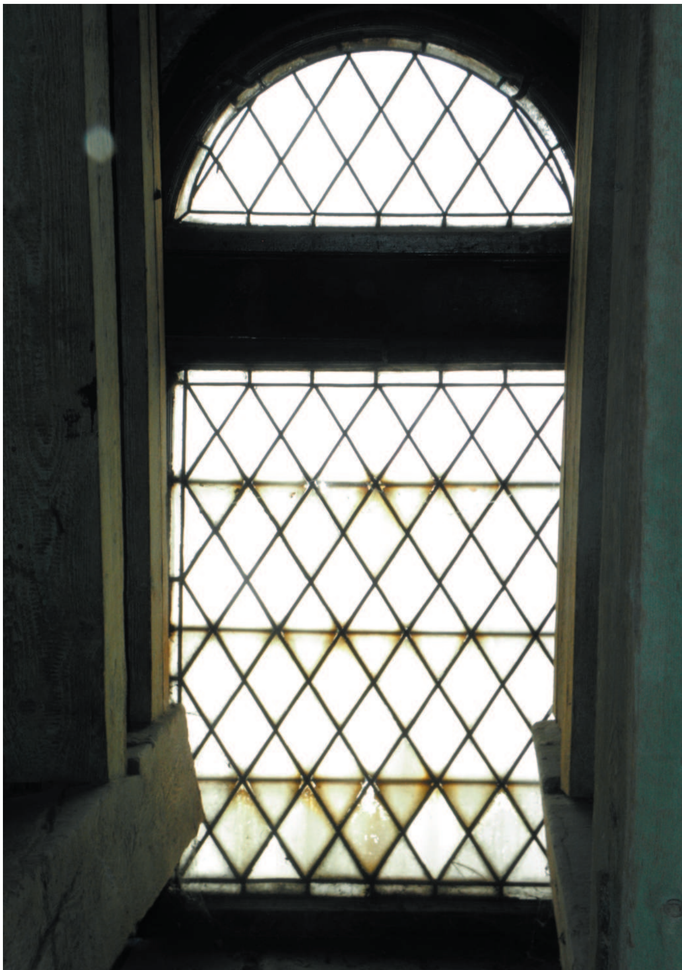
Vitraj okna šestého štítu levé strany radnice. Vitraj je dožilá. Má na dvou místech poškozená skla. Plocha je značně uvolněná a znečištěná.
