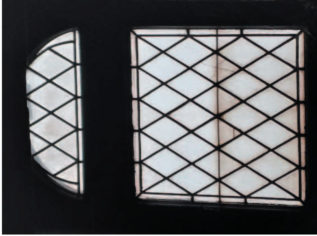
Vitrage horního a dolního okna velkého štítu umístěné v levé místnosti. U horního okna jsou ve spodní výplni poškozeny dva kosočtverce a u výplně dolního okna v horní části schází jeden díl bordury a výplň je uvolněná v horní části z rámu.
