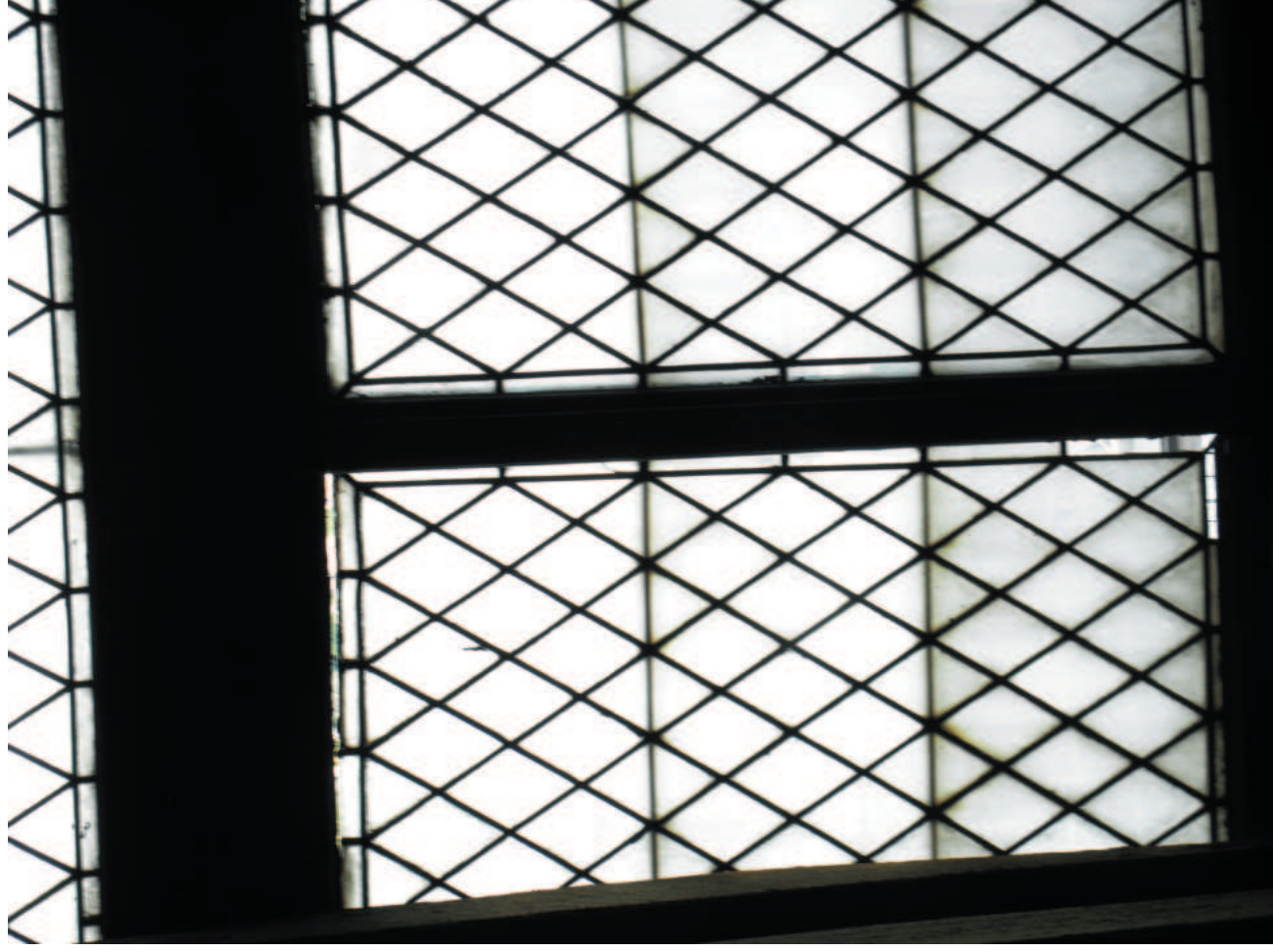
Okno středového štítu levé strany radnice. Vitraj okna je dožilá. Výplně jsou uvolněné. Levá spodní výplň je v horní i dolní části poškozená. Nahoře je také uvolněná z rámu okenního křídla.
