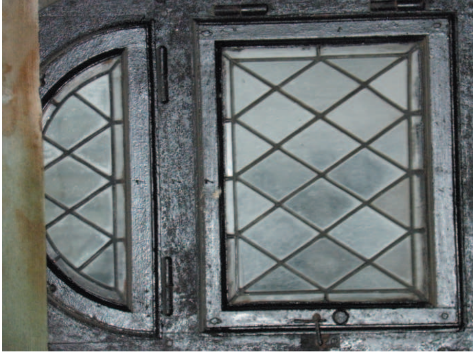
Malá okénka s vitrajemi pravé půdní místnosti směřující do atria radnice. V jednom okénku schází spodní vitrajová výplň. Místo ní je vložen rám opatřený pletivem. Ostatní výplně okének jsou dožilé
