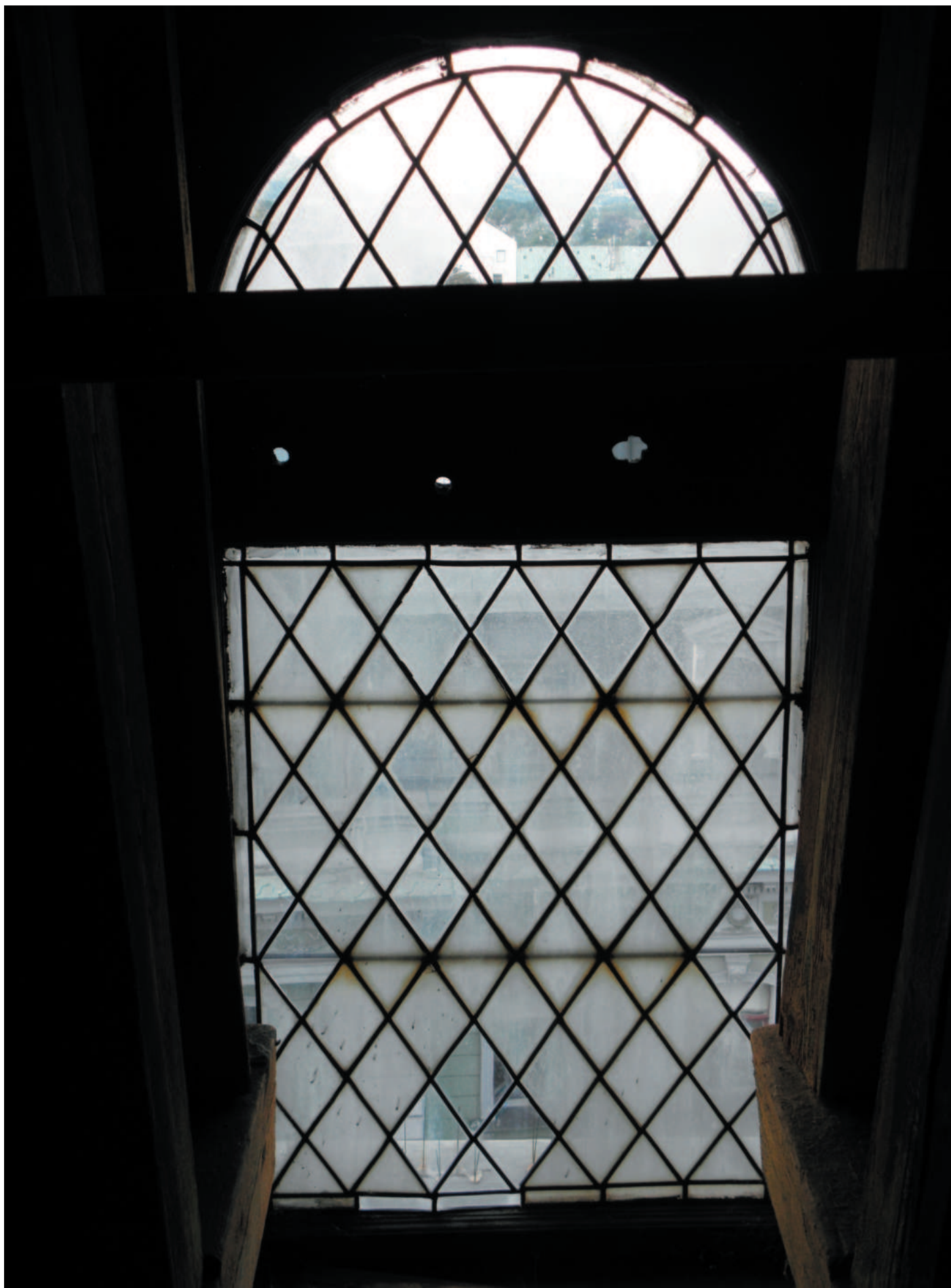
Okno druhého štítu. Vitrajové výplně jsou dožilé, velmi znečištěné a v ploše uvolněné.
