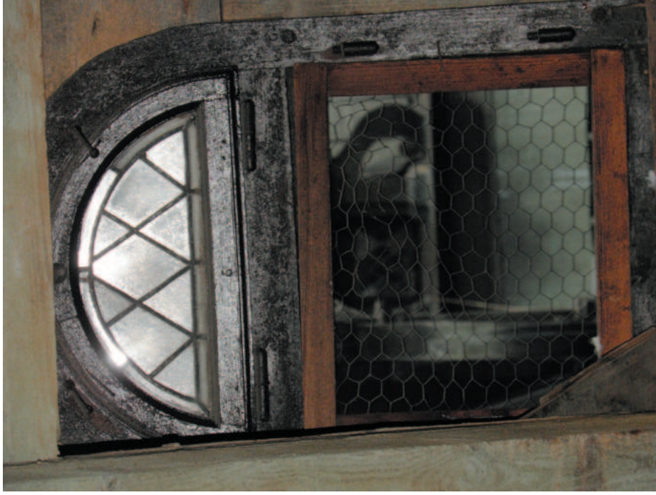
Malá okénka s vitrajemi pravé půdní místnosti směřující do atria radnice. V jednom okénku schází spodní vitrajová výplň. Místo ní je vložen rám opatřený pletivem. Ostatní výplně okének jsou dožilé
