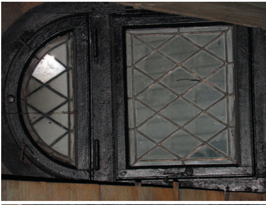
Malá okénka s vitrajemi pravé půdní místnosti směřující do atria radnice. V jednom okénku schází spodní vitrajová výplň. Místo ní je vložen rám opatřený pletivem. Ostatní výplně okének jsou dožilé
