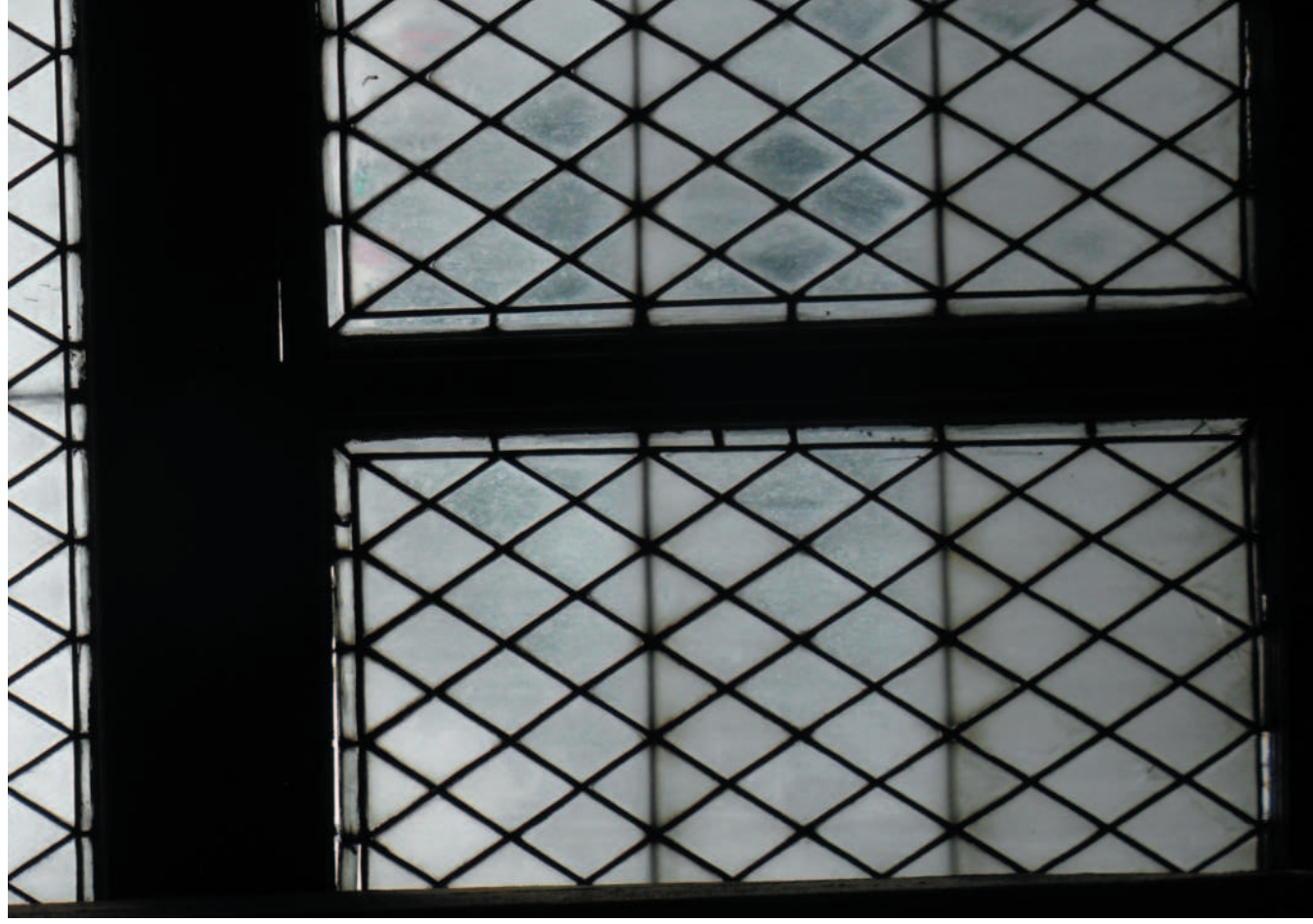
Okno s vitrají čtvrtého portálu. Spodní dvě výplně okna jsou již uvolněné v horních a dolních částech z křídel rámu.
