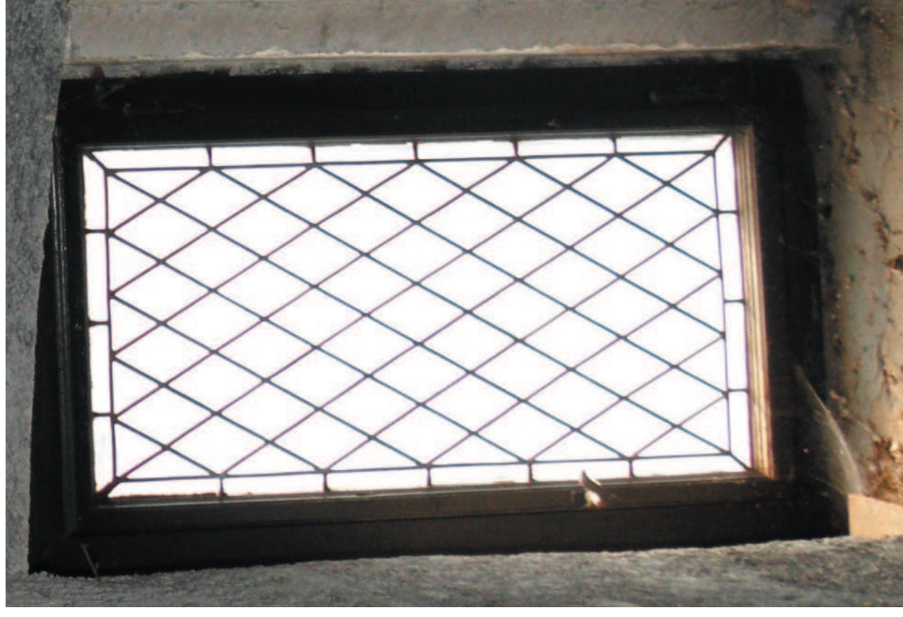
Bližší pohled na vitraje dvou oken velkého portálu. V jedné výplni je prasklý jeden kosočtvercový díl. U obdélníkového okenního rámu scházejí u výplně zpevňovací kovové výztuhy.
