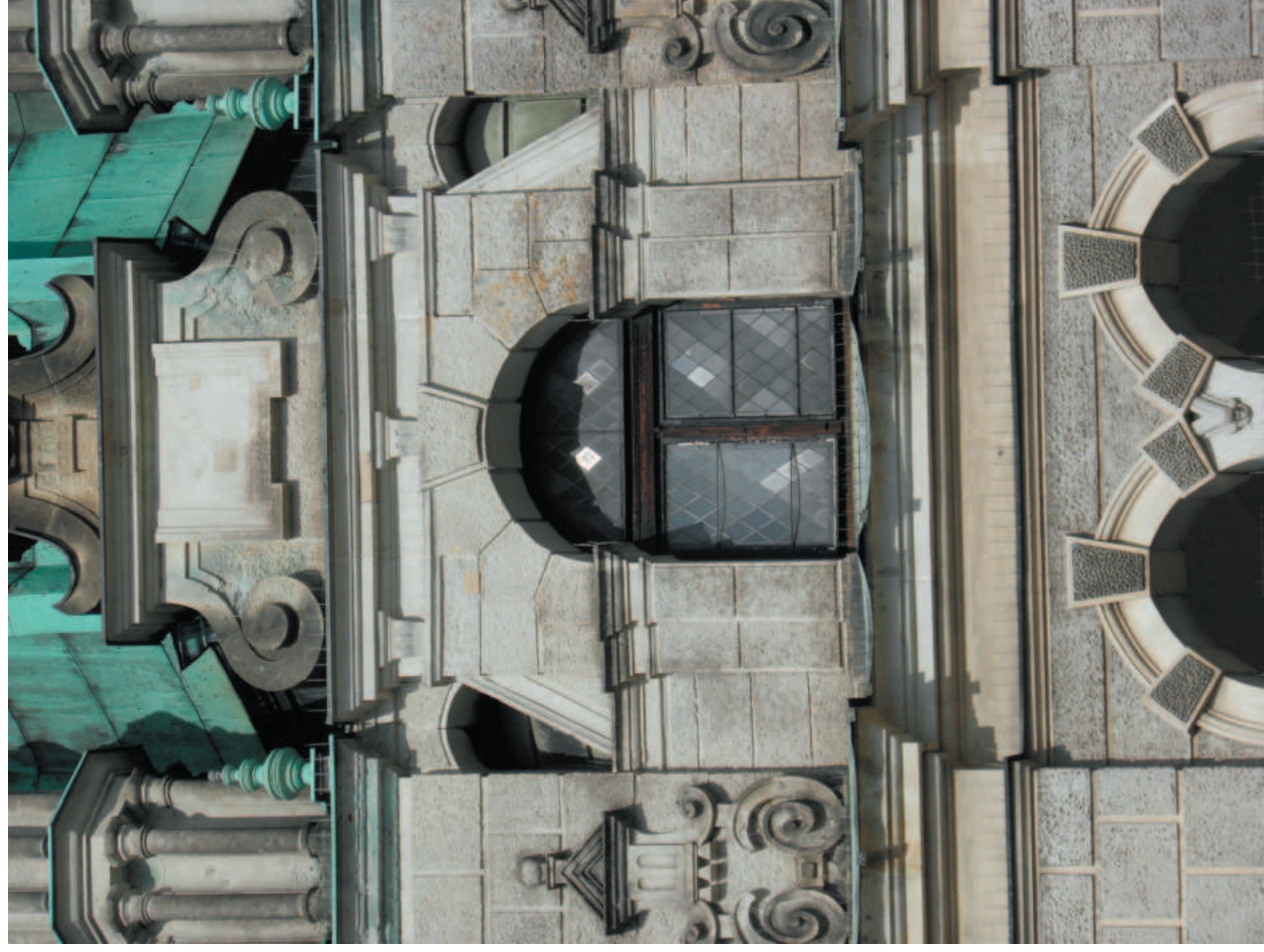
Pohled na pravou věž přední strany radnice z přední a pravé strany s okny osazenými vitrajemi. Ve střední části věže je opět osm menších okének osazených vitrajemi. Po stranách věžních štítů jsou opět zaslepené trojúhelníkové otvory. Na výplních dolních oken je vidět zvlnění ploch výplní. Jsou zde vidět i uvolněné kovové výztuhy které již neplní svou zpevňovací funkci.
