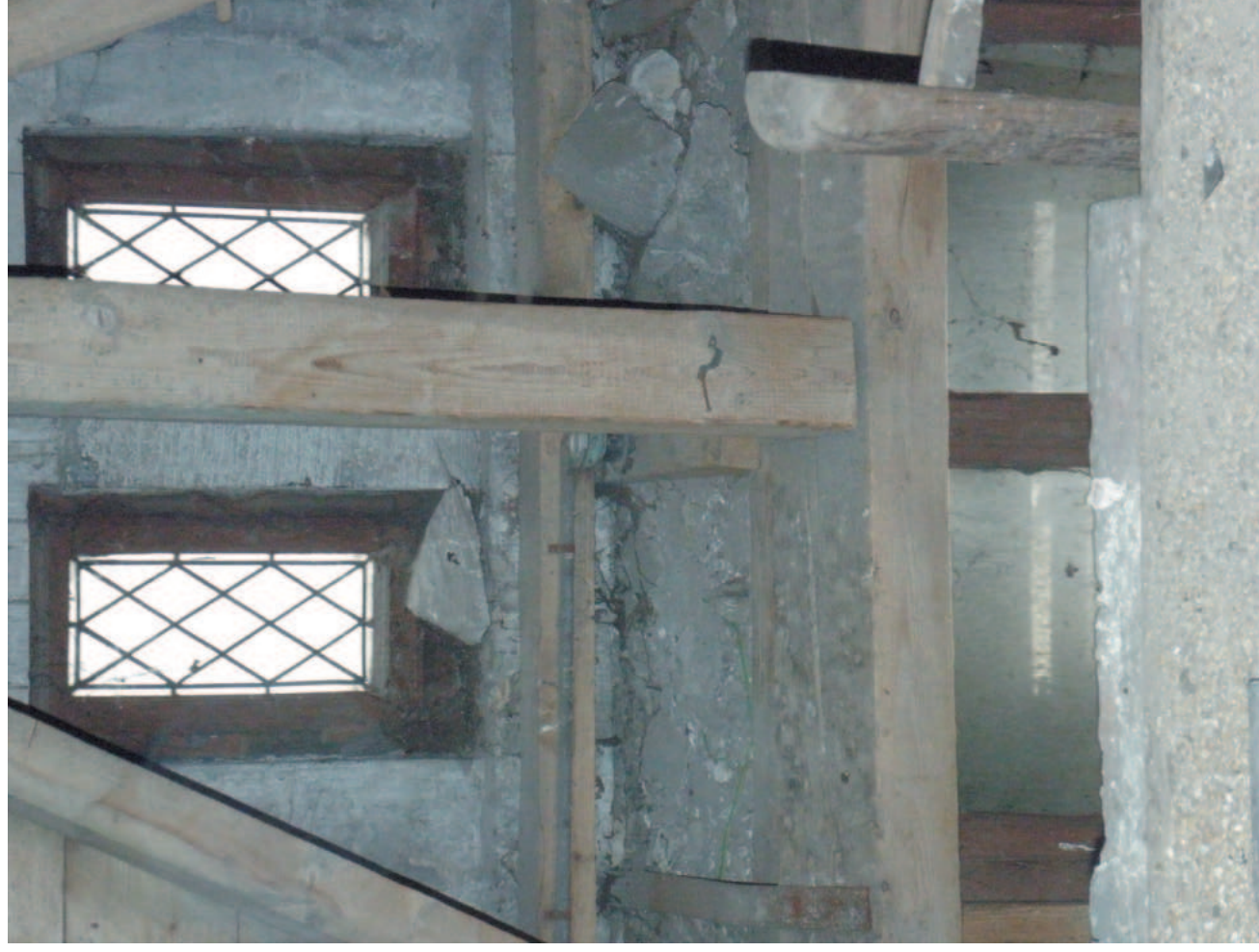
Štít přední strany levého propadliště. Z vnitřní strany jsou vidět jen zlomky vitrají. Na snímku z exteriéru jsou vidět vitraje zachovalé v celé ploše. Jejich plocha je již uvolněná a zvlíná . U spodní výplně je odpadlá horní kovová výztuha. Vitraje jsou dožilé.
