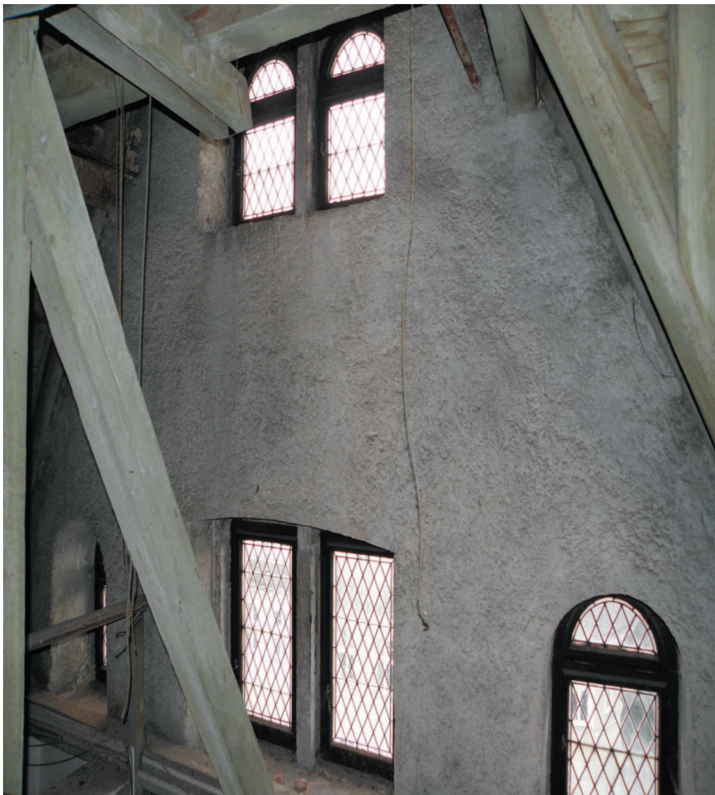
Okna pátého, velkého portálu pravé strany radnice. Vitraje oken jsou také dožilé.
