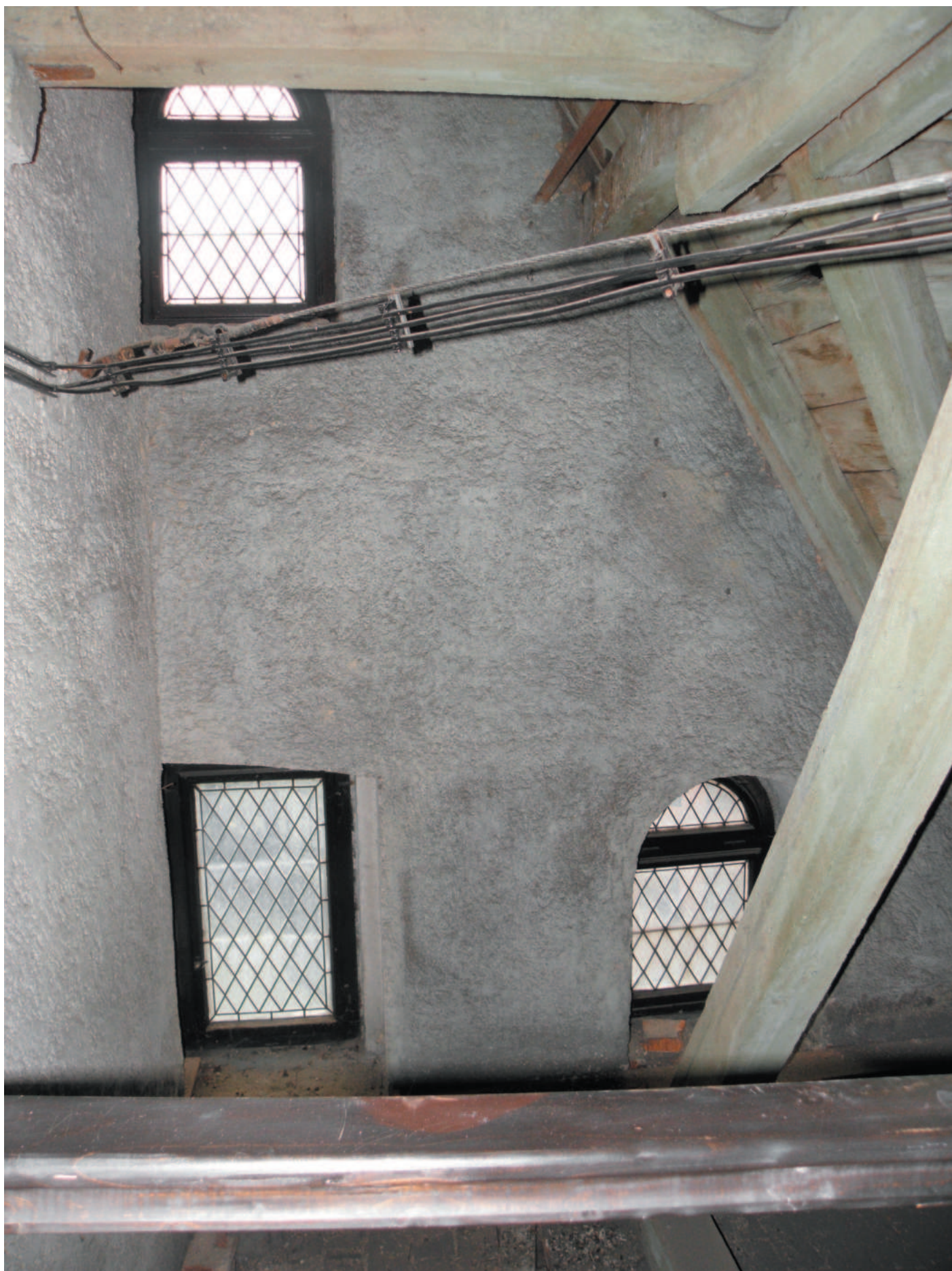
Polovina oken s vitrajemi třetího, velkého portálu. Druhá polovina oken je za dělicí stěnou která odděluje pření půdní místnost od následující pravé půdní místnosti. Plochy vitraji jsou kompletní ale olověná vazba je dožilá.
