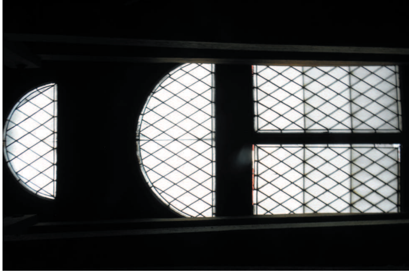
Okno středového štítu levé strany radnice. Vitraj okna je dožilá. Výplně jsou uvolněné. Levá spodní výplň je v horní i dolní části poškozená. Nahoře je také uvolněná z rámu okenního křídla.
