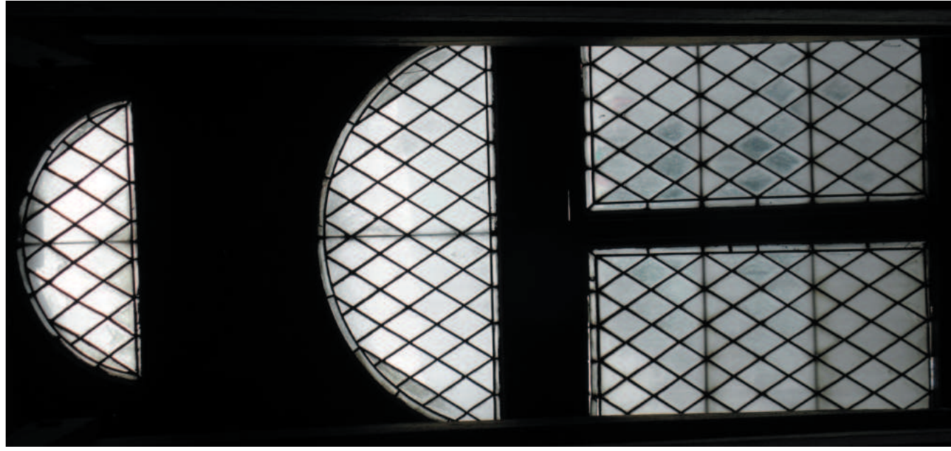
Okno s vitrají čtvrtého portálu. Spodní dvě výplně okna jsou již uvolněné v horních a dolních částech z křídel rámu.
