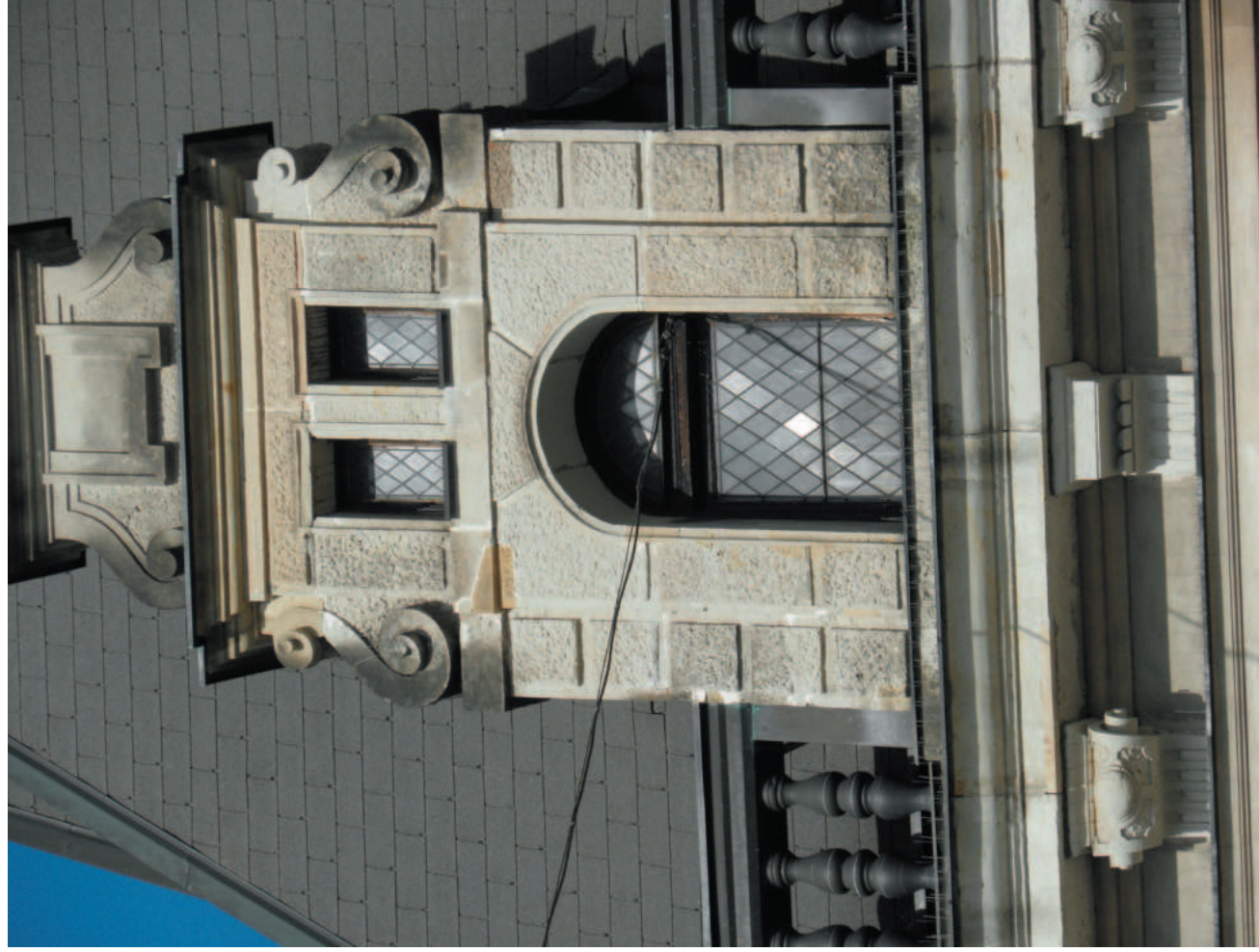
Štít přední strany levého propadliště. Z vnitřní strany jsou vidět jen zlomky vitrají. Na snímku z exteriéru jsou vidět vitraje zachovalé v celé ploše. Jejich plocha je již uvolněná a zvlíná . U spodní výplně je odpadlá horní kovová výztuha. Vitraje jsou dožilé.
