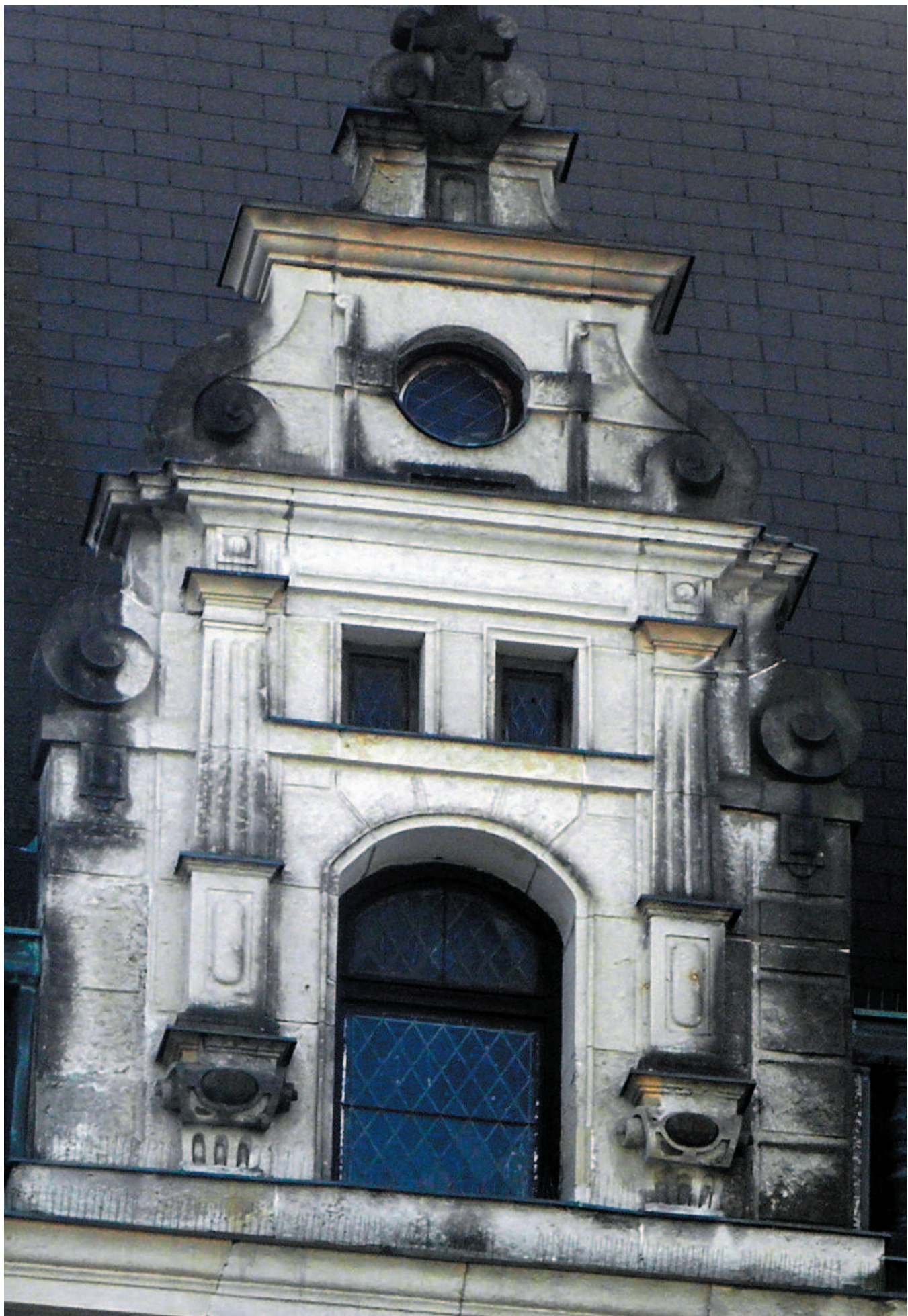
Druhý portál půdy. Výplně všech čtyř oken jsou v ploše zachovalé. Jejich plochy jsou deformované a jejich skla jsou nánosem nečistot slepá. Vitraje jsou dožilé. Přístup z vnitřní strany k oknům s vitrajemi je omezený.
