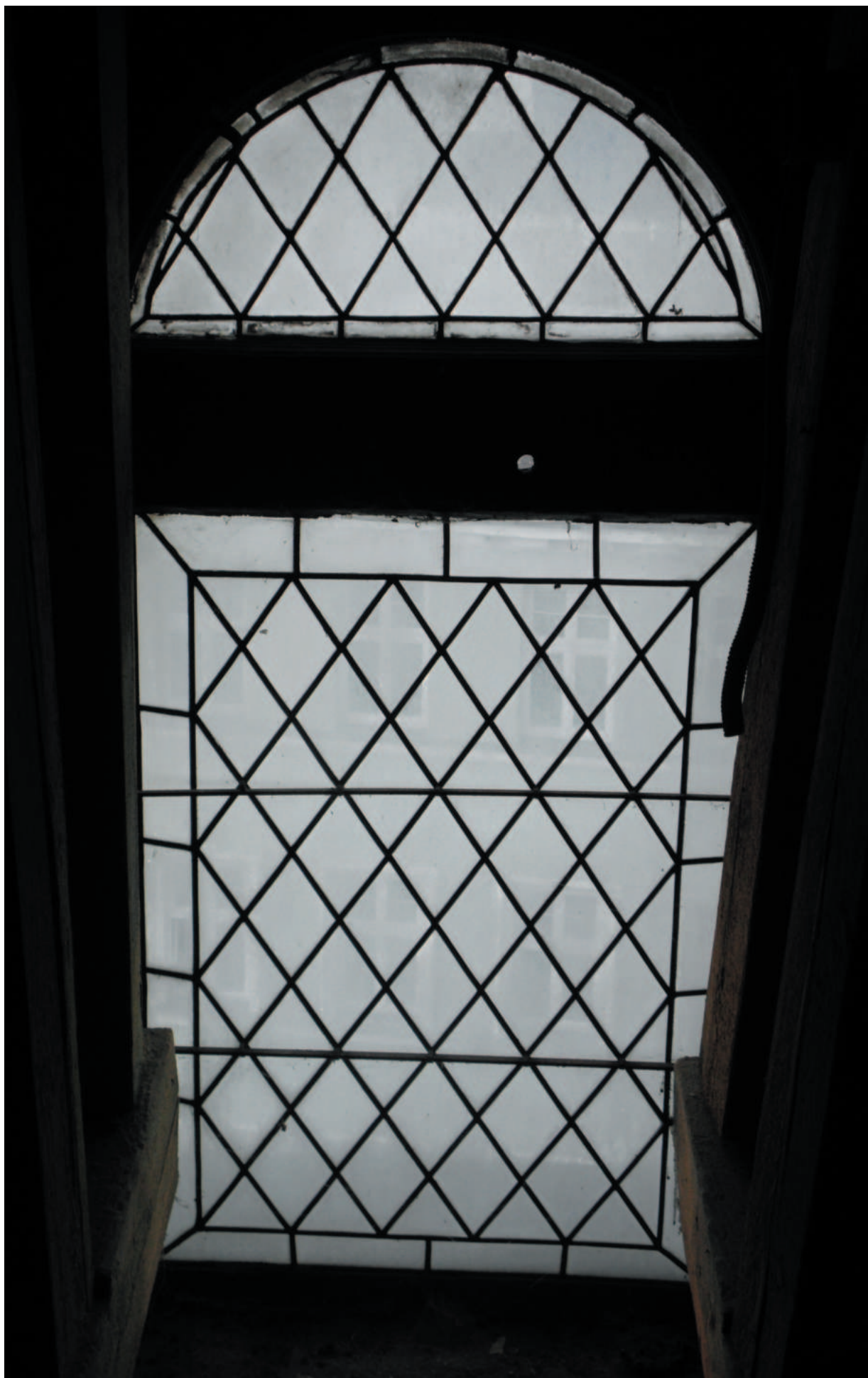
Okno s vitrají šestého portálu pravé strany radnice. Horní výplň je původní. Spodní výplň byla v minulosti nahrazena novou velice neodborně vyrobenou výplní. Kosočtverce i bordura jsou v jiném rozměru než byly v originále.
