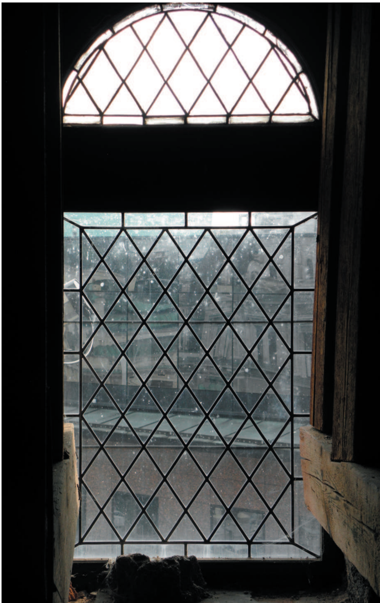
Okno s vitrají druhého portálu. Vrchní výplň je původní a je ve špatném stavu. Spodní výplň vypadá že byla ve vzdálené minulosti přeložena. Je v lepším stavu. Ale při přesazení výplní do nových rámců bude třeba obě výplně přeložit.
