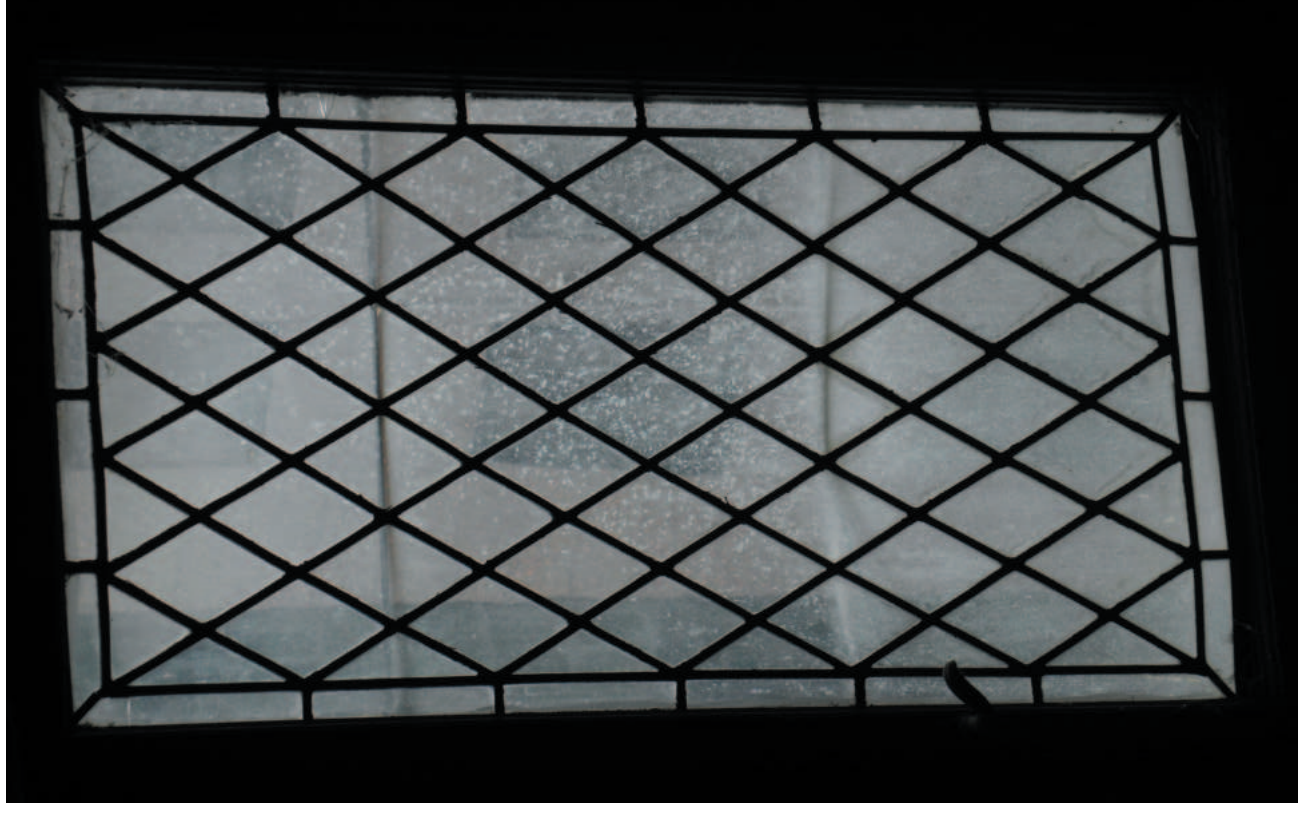
Bližší pohled na dvě výplně velkého portálu. Plochy výplní oken jsou zvlněné. U výplně obdélníkového rámu jsou odpadlé kovové výztuhy a na jejích místech je jen jejich špinavý otisk.
